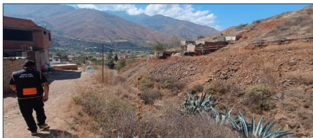
Panorámica de la Quebrada Lindero en un entorno semiurbano, mostrando el cauce erosionado y una ladera inestable que amenaza un camino y las edificaciones cercanas en la parte superior.
